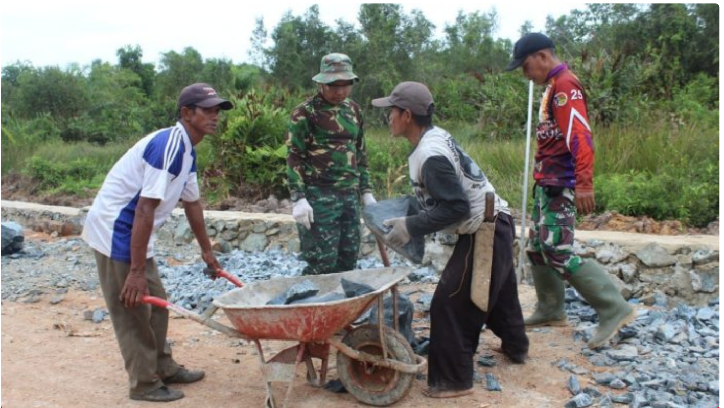
Personel Satgas TMMDKe - 117, Kerjakan Siring Jalan
