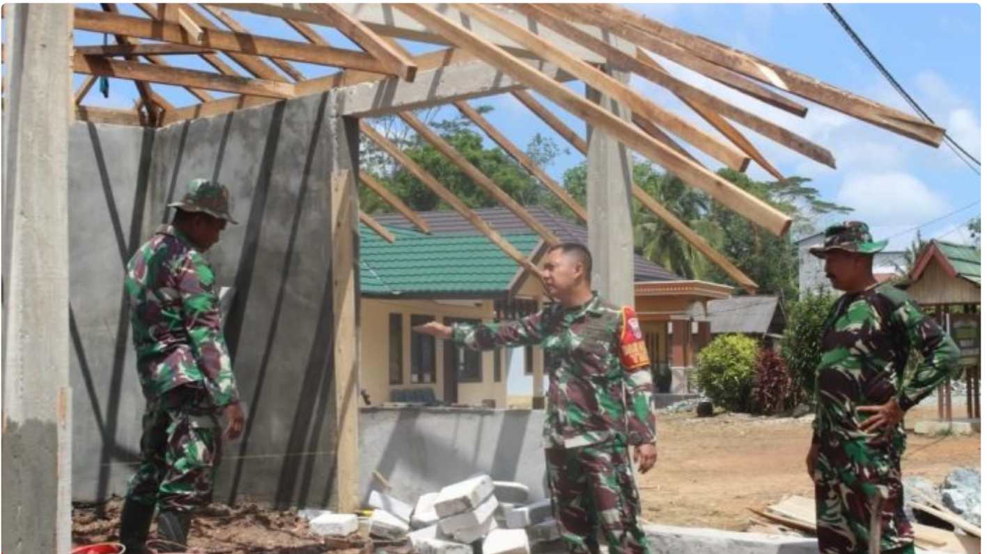
Dansatgas TMMD, Tinjau Langsung Perkembangan Dilapangan
