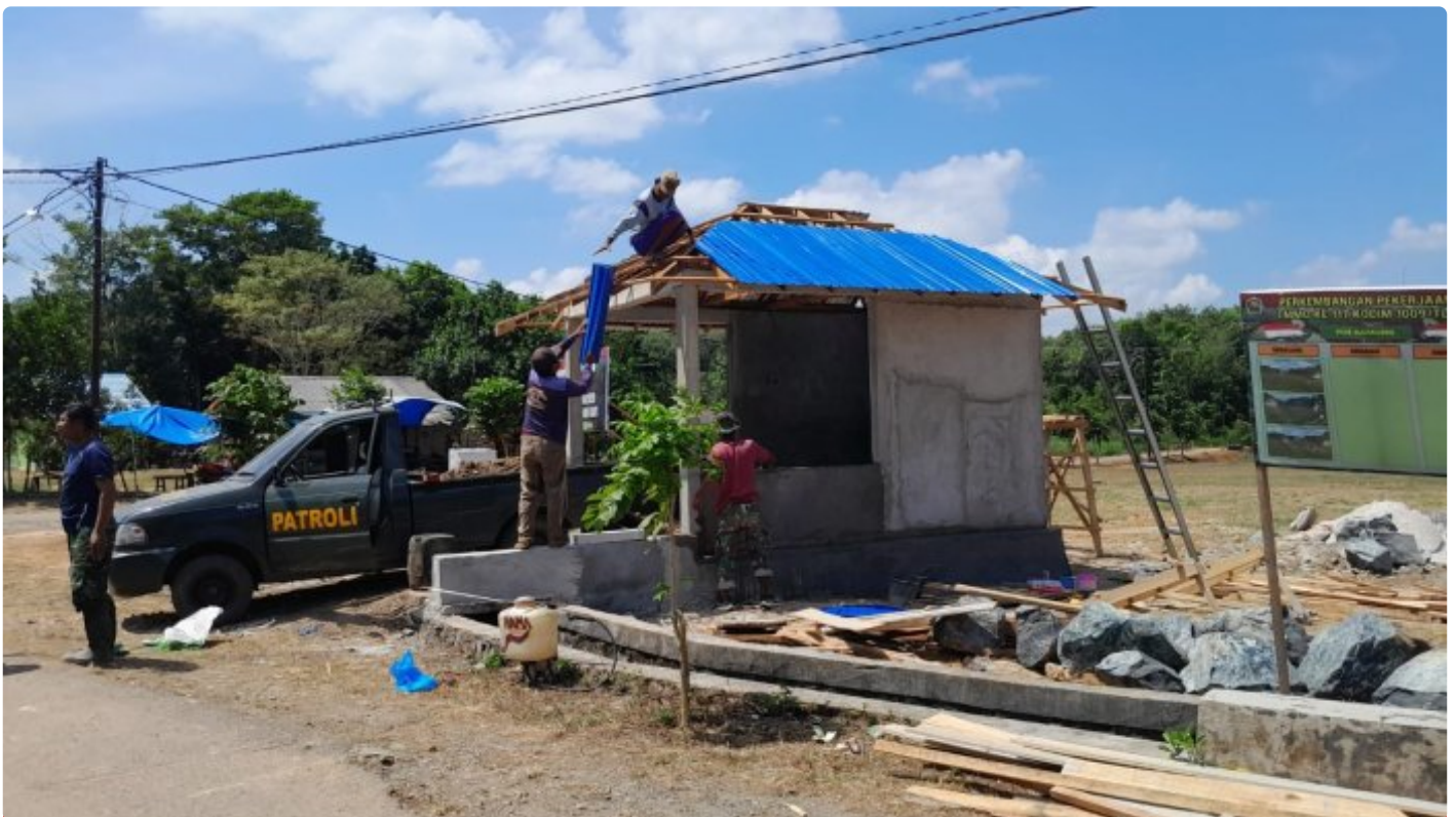
Atap Seng Pos Kamling Mulai Dipasang Oleh Satgas TMMD
